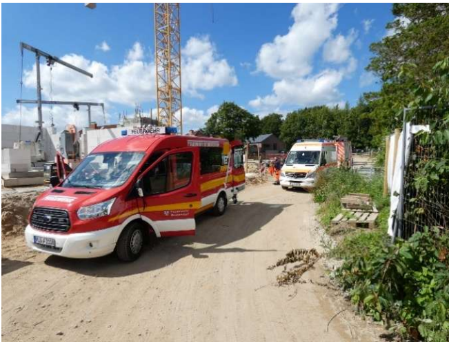
Abbildung 1 Technische Hilfe, Verletzte Person auf Baustelle
